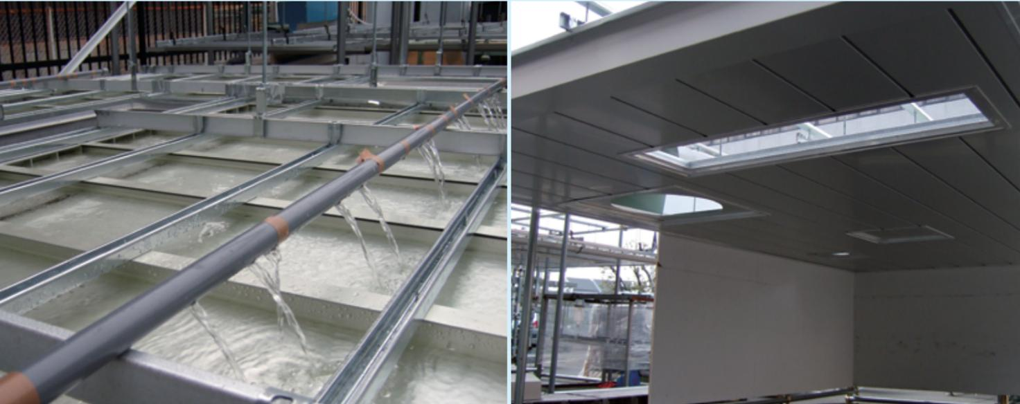
現在、高架下駅や地下駅等の駅舎天井では、漏水問題が深刻化しています。ボード系材料が水分を吸収してもろくなり、落下する事象が発生しているのです。中でも、高架下駅においては、高架橋から流れ出る雨水の問題が懸念されています。漏水を完全に防ぐことは困難で、対策としては二重天井で雨水を防ぐという方法が考えられます。ただ、既存高架橋の寸法上、天井が二重となる仕様により天井高が抑えられ、通行するお客さまの快適性を制限する一因となってしまいます。そこで弊社ではJR東日本と共同で、これら別々の性能を持つ天井を一体化し、問題点を解決した商品「流水システム天井」を開発致しました。見た目も従来の金属天井の良さを取り入れ、意匠性にもすぐれており、漏水の多い高架下駅には最適です。
