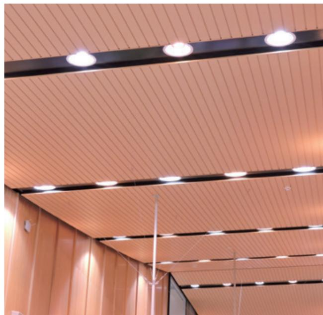
素材は、アルミニウム板に塩化ビニルシートを貼り合わせたポリ塩化ビニル被覆金属板で、アルミニウムの優れた特長と塩化ビニルの持つ豊かな装飾性を兼ね備えています。
