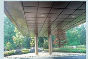
FRAME IN 工法とは、パネル落とし込み施工のことで、スラブより吊ボルトを吊り下げ、Tハンガーを取り付けてTバーを架設。TバーT孔にクロスバーを挿入し、各部を固定。パネルを下部より斜めに入れ、水平にして上部より落とし込みます。(直吊り) さらに、吊り元の位置が不的確な場合、またはTバー組がより正確でより安定を求められる場合は、野縁受け(38チャンネル)と間隔ハンガーを使って組み立てる方法もあります。(二重吊り)
