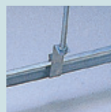
ハンガー(CH) 野縁受け吊り金具
